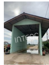
โรงสเปรย์พ่นน้ำยาฆ่าเชื้อ ก่อนเข้าภายในฟาร์ม
